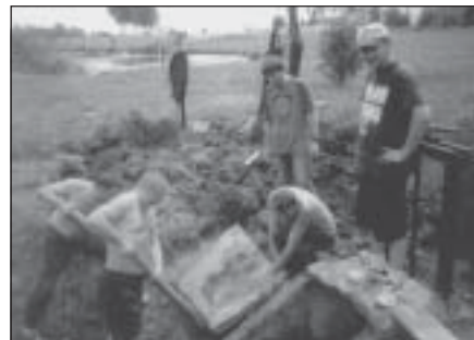
Uszczelnianie przepustu to ciężka praca.
