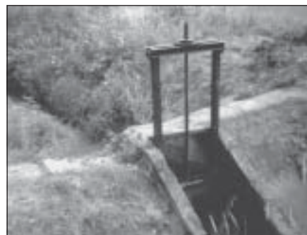
Po zakończeniu prac (dziś już obie strony są uszczelnione).
